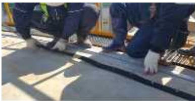
(4) 플랜지 앙카 및 가스켓 설치
