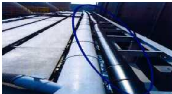
〈 안정화조 Common 가스배관 설치 〉
